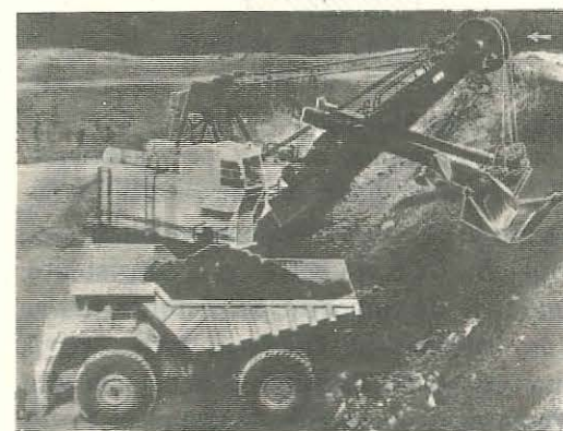
Fig. 2.53. Folosirea scripetelui fix la un excavator.
