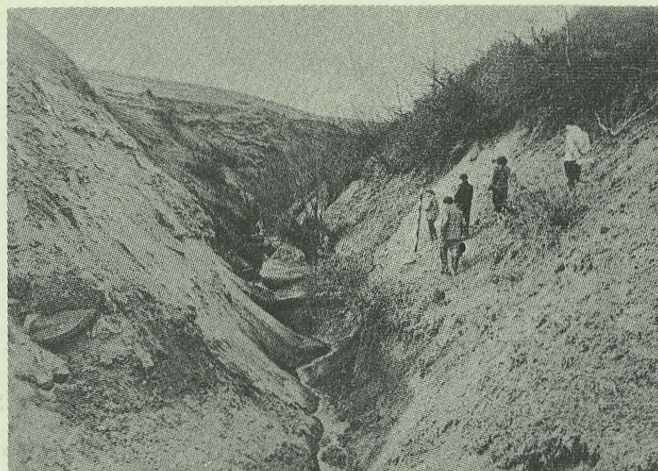
Canalul de scurgere al unui torent.
