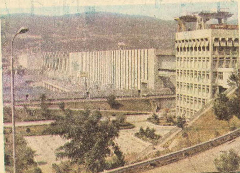
Hidrocentrala «Porțile de Fier I»
