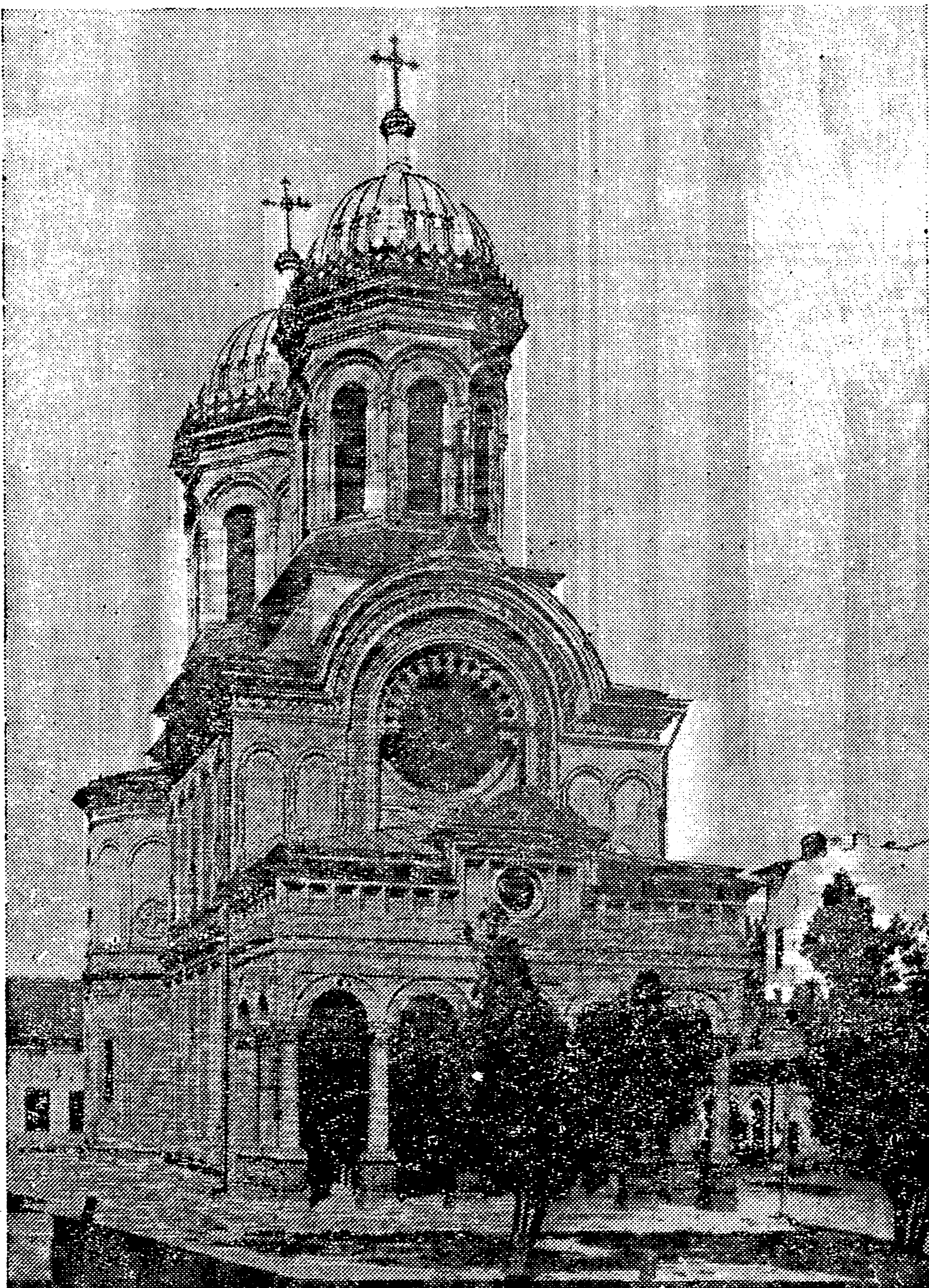
Biserica mare. Tencuiala fațadei și rozetele din ipsos, montate în 1860, grav deteriorate. Fotografie din anul 1925.
