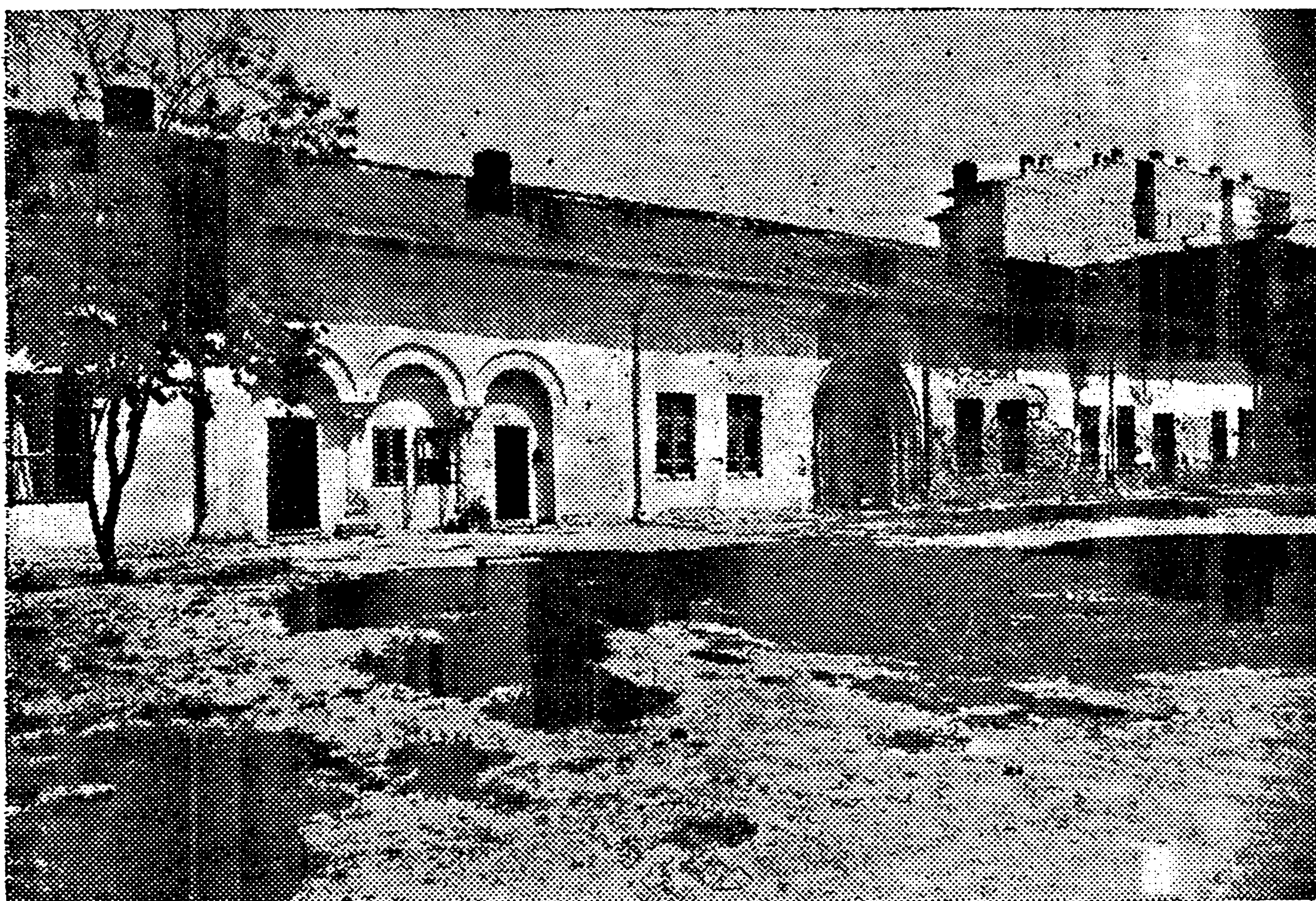
Chiliile, latura dinspre răsărit, în ruină (anul 1925). De remarcat lipsa arcadei din dreapta fotografiei ; arcada este mascată de zidul construit ulterior. Sub tencuială se observă însă arcele de zidărie de deasupra coloanelor. Turnul din colț complet dărîmat.
