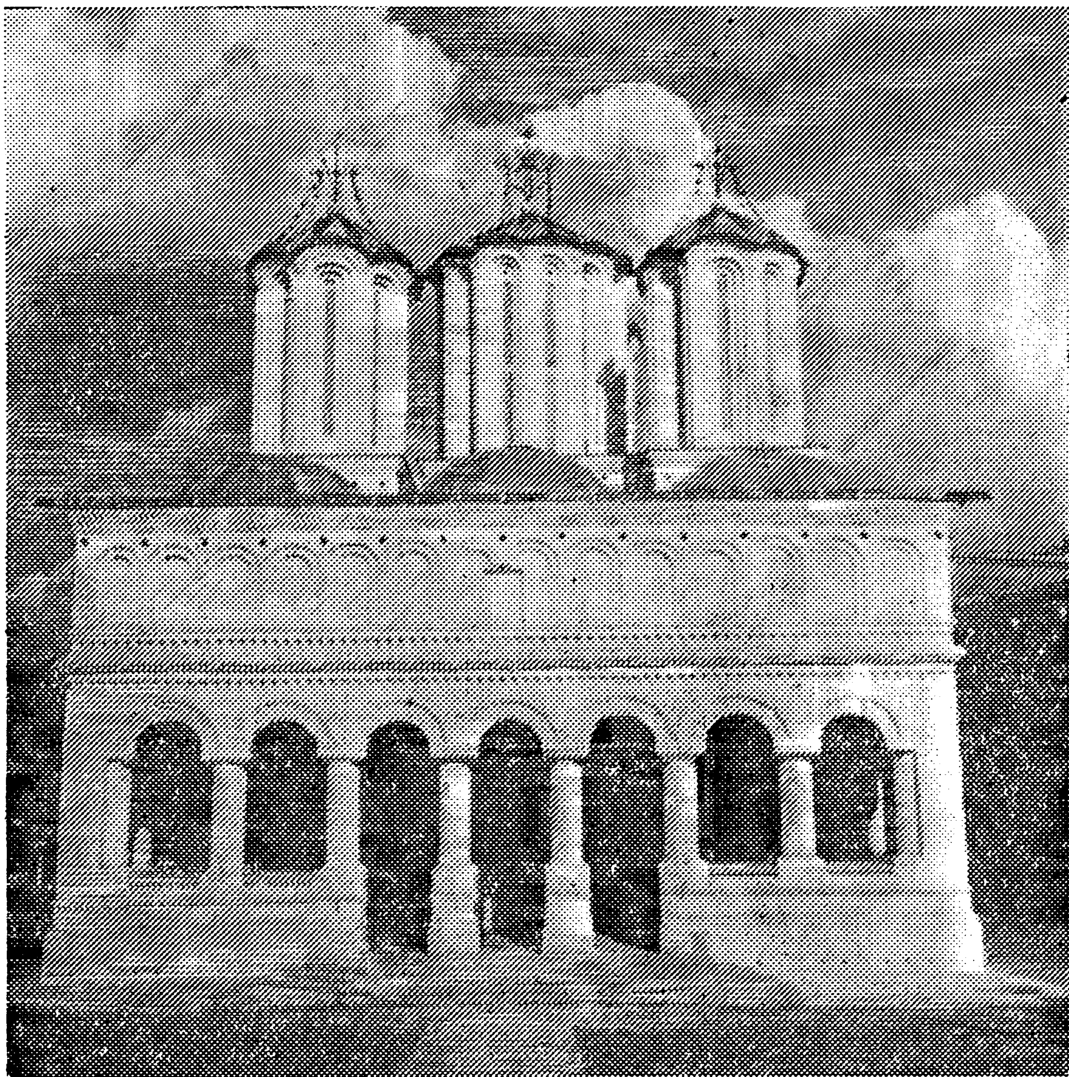
Catedrala patriarhală după restaurare. — Vedere dinspre apus.
