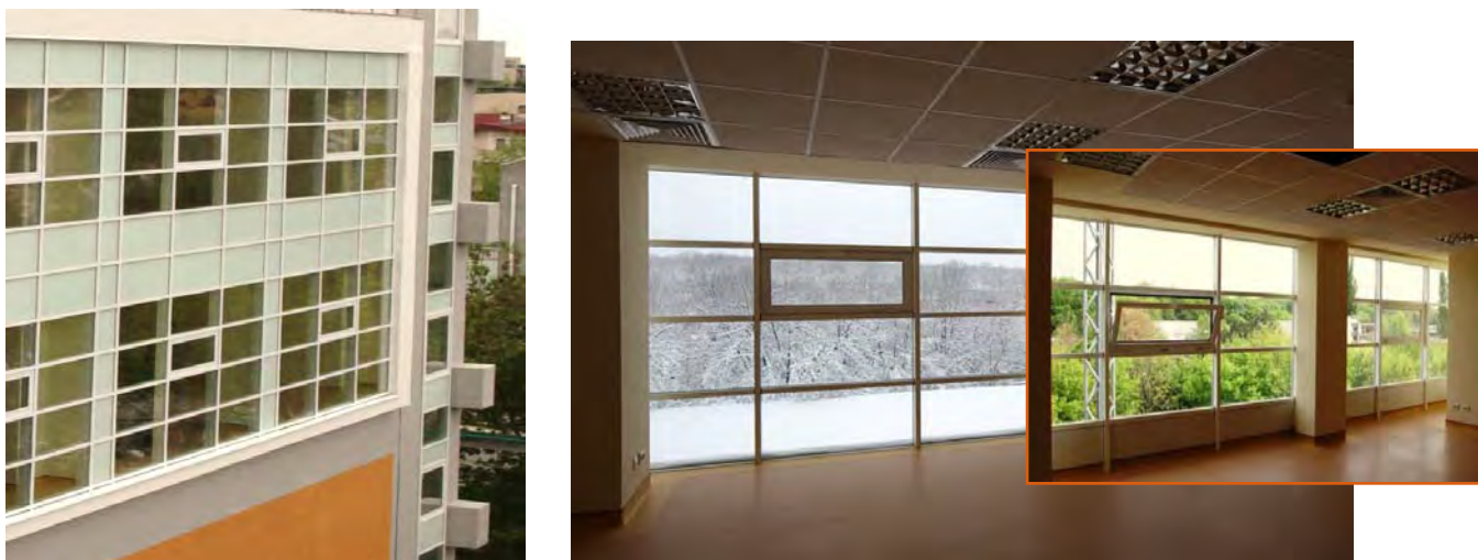
Imagini ale construcției pentru noul centru CENASIC, realizată prin demolarea unei porțiuni dezafectate din hala tehnologică a institutului
